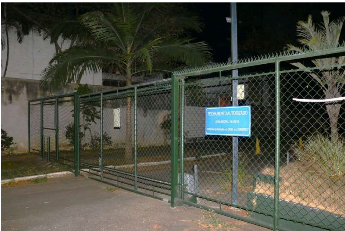
Imagem 5: As grades de um portão instalado na rua Romão Gomes sob a lei municipal 16.439 de 2016.
