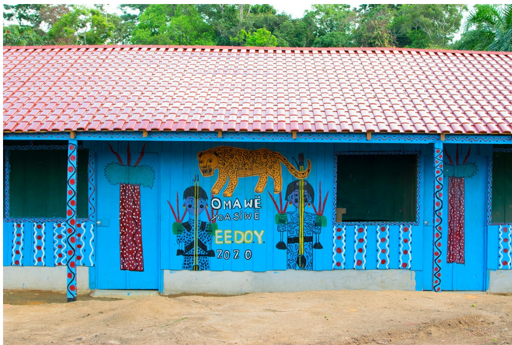
Fachada principal da Escola Omawë Yanomami, comunidade Pukima Cachoeira, rio Marauaiá, Terra Indígena Yanomami (AM). Foto: Daniel Jabra e Thiago Benucci, 2020.
