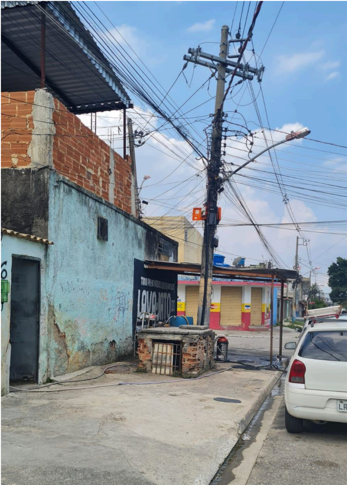
Figura 1 - Primeira Bomba d'água da Carolina
