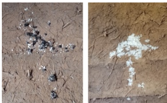
Imagens 01 e 02: fungos na parede indicando que a parede estava seca / pronta.
