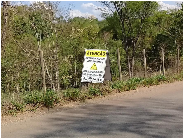
Imagem 07. Aviso do processo de demolição nas margens da rodovia MG 040. Registro no dia 05/10/2022.
