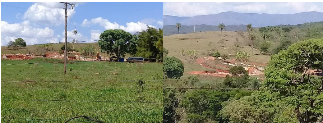
Imagens 8 e 9: Registro da segunda fase de demolição (mesmo local da foto 7), com as máquinas executando parte da destruição e retirada dos escombros, dia 05/10/2022. Comunidade Melo Franco. Foto: Alexandre Gonçalves.
