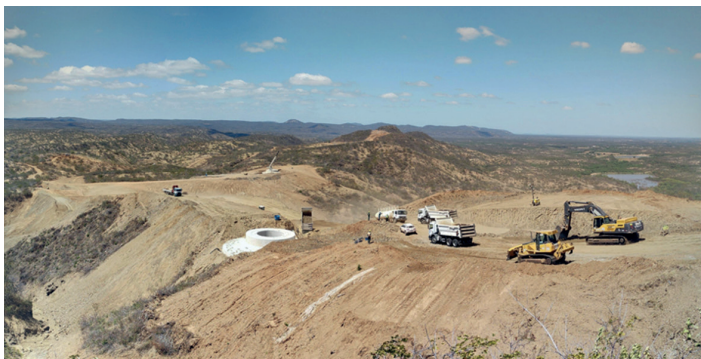
Figura 1. Desmatamento e terraplanagem na Serra do Piauí para instalação do Complexo Eólico Anemus Wind. Limite entre os municípios de Currais Novos e São Vicente (RN), 2023. Fotografia: Acervo Seridó Vivo.
