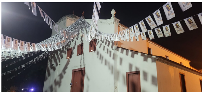
Figura 1. O telhado mais baixo (à direita) é da Capela de São Benedito, e a igreja principal (à esquerda) é a dedicada à Nossa Senhora do Rosário. Cuiabá, 2023. Fotografia: Flávia Carolina da Costa.
