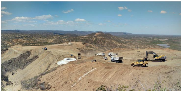
*Figura 1. Desmatamento e terraplanagem na Serra do Piauí para instalação do Complexo Eólico Anemus Wind. Limite entre os municípios de Currais Novos e São Vicente (RN), 2023. Fotografia: Acervo Seridó Vivo.*
